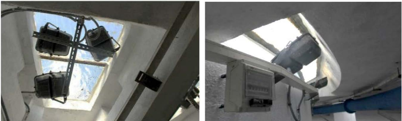
Figura 1. Iluminación mediante proyectores situados en sala de máquinas, debajo de un lucernario. Fuente de San Juan de la Cruz en Madrid. C. de la Fuente (2018).
